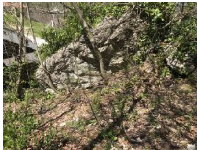
Foto 6: massi instabili presenti lungo il versante da disaggiare e consolidare;
