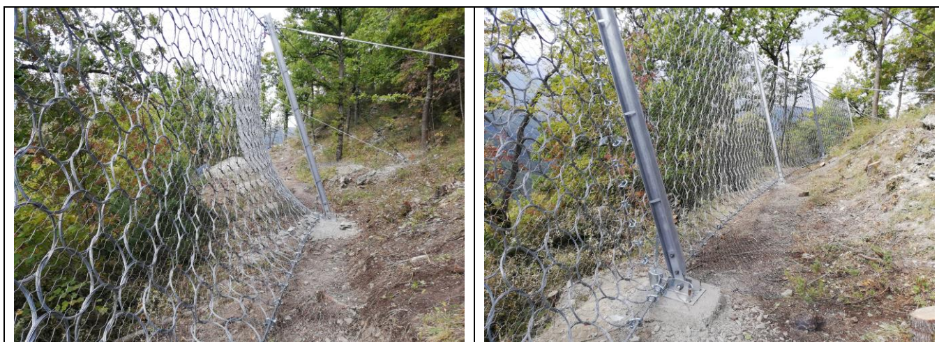
Foto 1: barriera paramassi esistente
